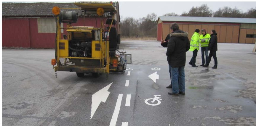
Bild 4, Exempel på symboler lagda med den nya metoden med 40 cm:s skopa
